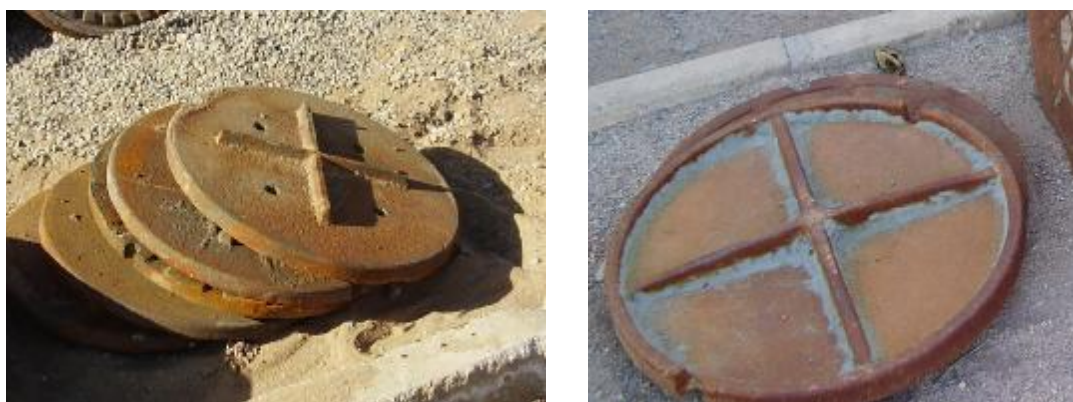
شکل 1-7- دریچه‌ی چدنی نوع ضربدری (انبار یزد)
