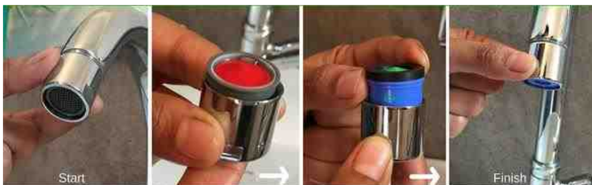
شکل ۲۴: نحوه تعویض یا نصب سرشیر
