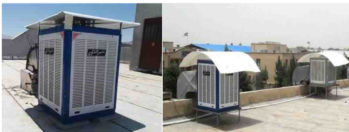
شکل ۳۰: نصب سایبان بر روی کولرهای آبی
