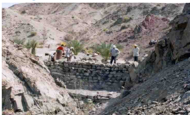
نمونه ای از احداث بند سنگی برای جمع آوری آب باران برای آبیاری نخلستان در هرمزگان
